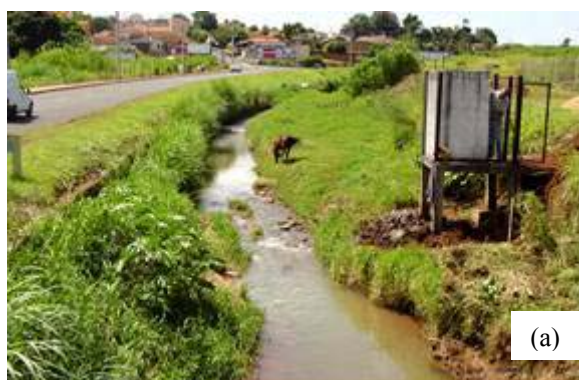
Figura 4- Escoamento no trecho de montante para y < y_{cb} (a) e y > y_{cb} (b) em uma seção de controle da bacia do Gregório (área de drenagem = 10,1 km 2 ). Fonte: FINEP/FIPAI-EESC/DAEE (2003) www.busplanodiretor.hpg.com.br
