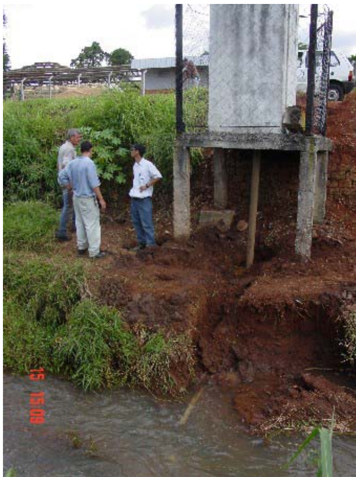
Figura 8. Instalação do linígrafo de pressão para medição do nível d'água no Córrego do Gregório.
